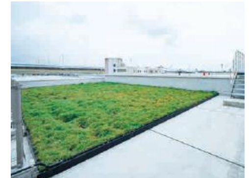
浦和支店 屋上緑地
